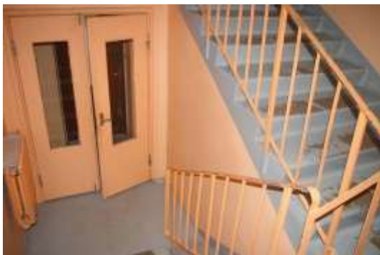
Dzīvojamā ēka ar kadastra apzīmējumu 6488 005 0045 001, koplietošanas telpa
